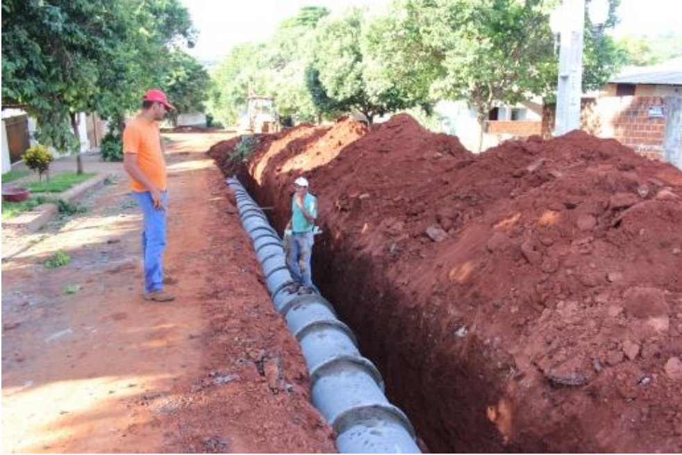
Figura 2– Linha principal de galeria de água pluvial.
