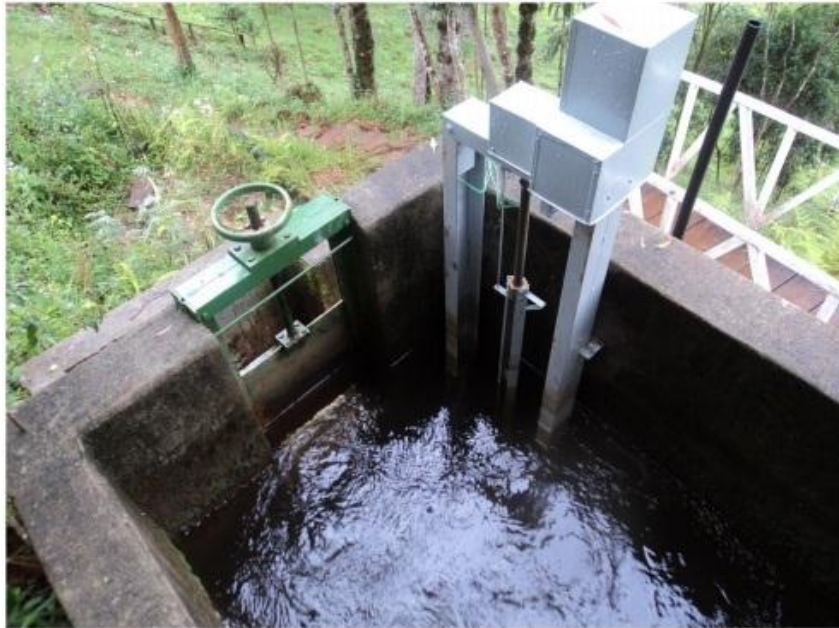
Figura 3: Comporta instalada na entrada da tubulação forçada
